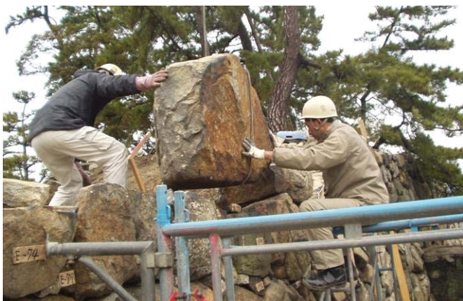
解体修理の状況
