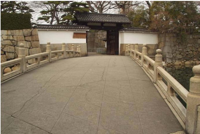
旭門に対して斜めに架かる旭橋
