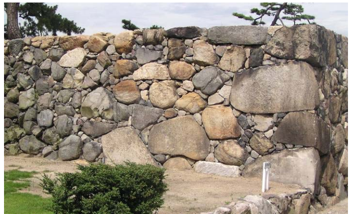
解体修理完成後の鉄門西面石垣
