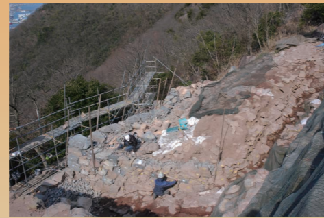
10. 城内側石積み解体前
