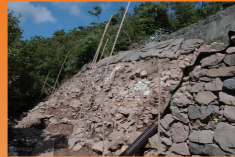
3. 丁張り設置状況
