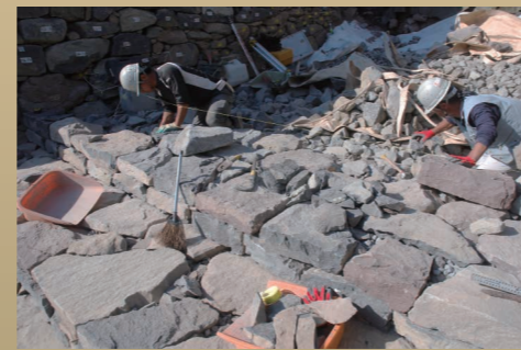
20. 門道石敷き状況①
