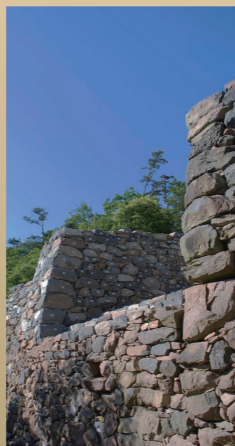
22. 完成した城門
