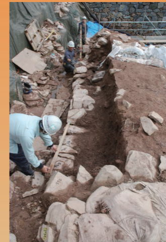
13. 城内側石積み ライン確認作業
