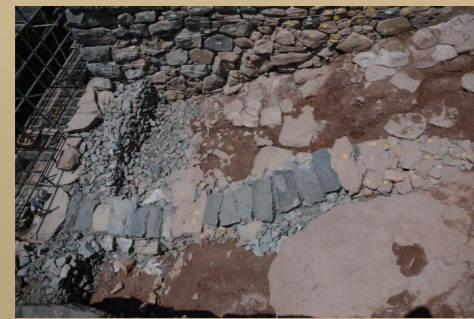
18. 排水溝修復完了状況
