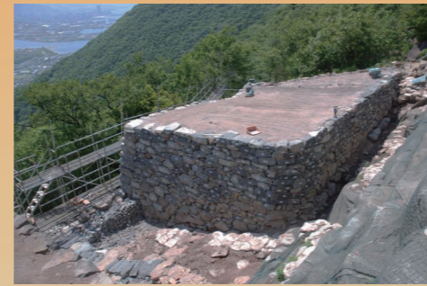
11. 城内側石積み修復状況
