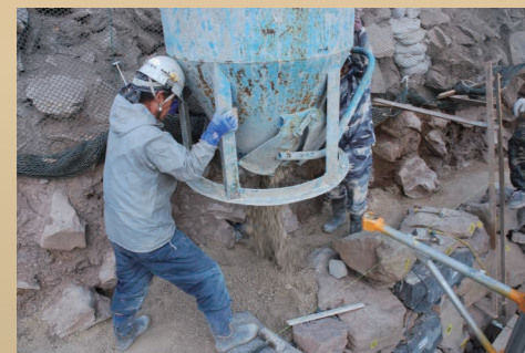
14. 盛土施工状況①
