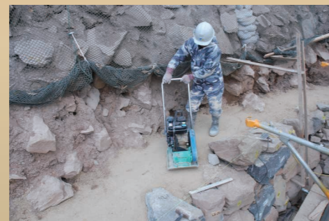
15. 盛土施工状況②
