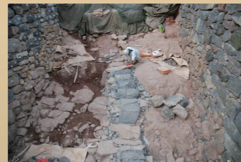
17. 排水溝設置状況
