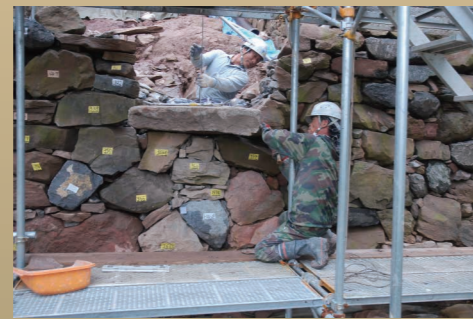
19. 水口修復状況
