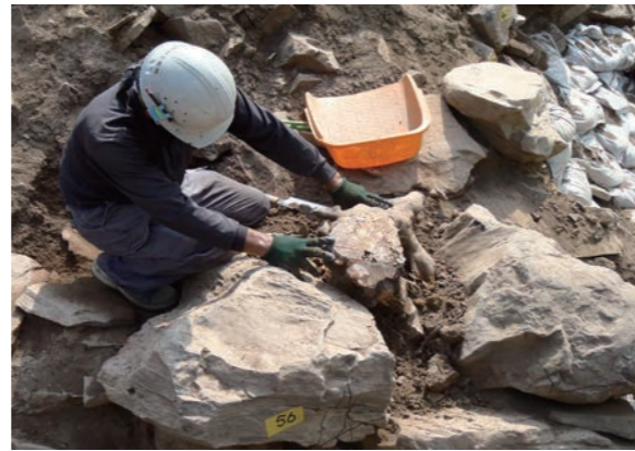
⑥木の根撤去状況
