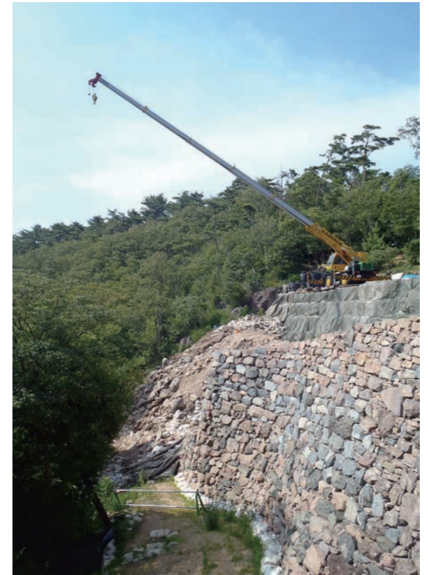
④施工状況
