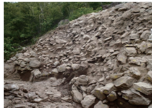
⑭石積み等撤去後状況①
