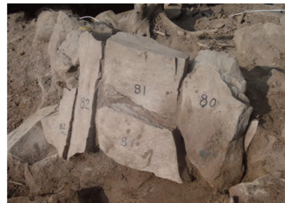
⑩築石割れ状況
