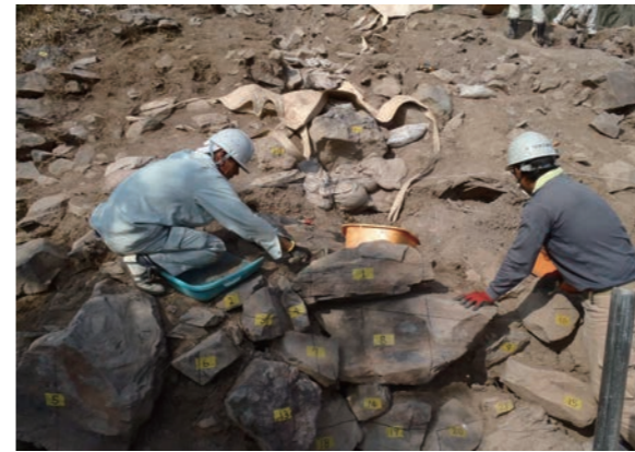
⑦盛土掘削状況
