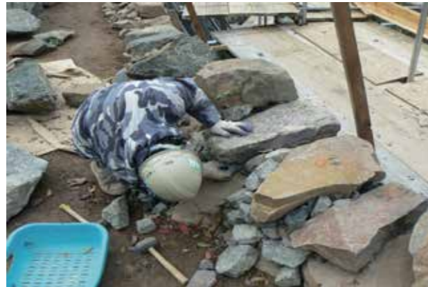
⑨飼石等施工状況
