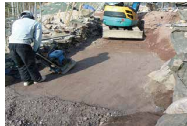
⑮盛土の転圧作業
