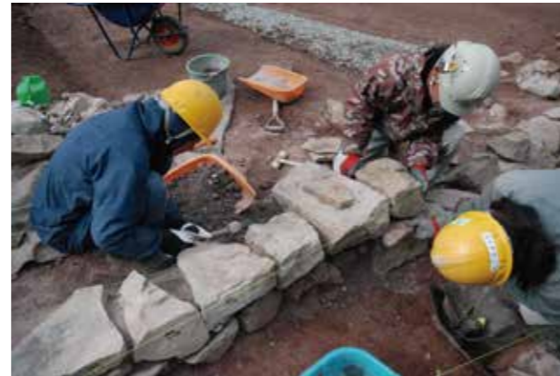
⑩築石背面盛土施工状況
