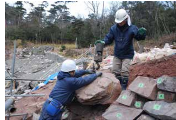
③石積みの解体状況
