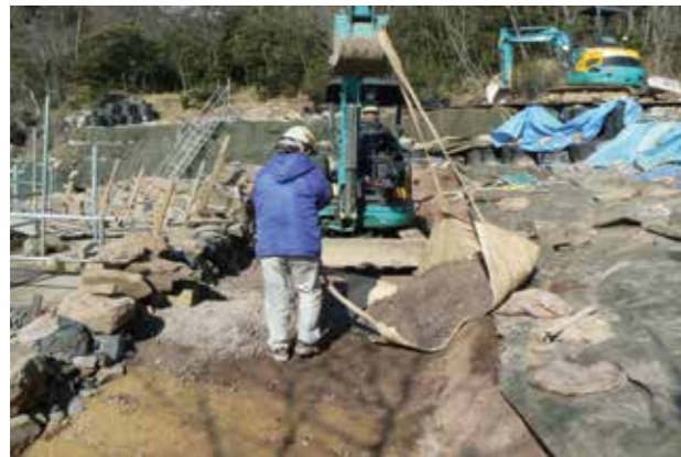
⑬盛土の撒きだし
