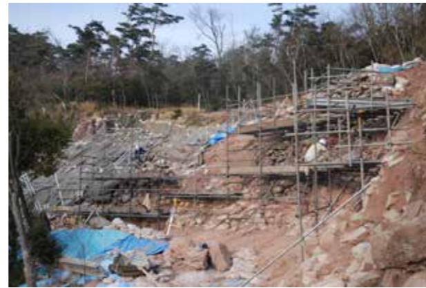
②解体前の状況
