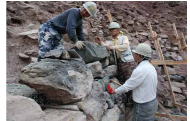
⑧石積み状況
