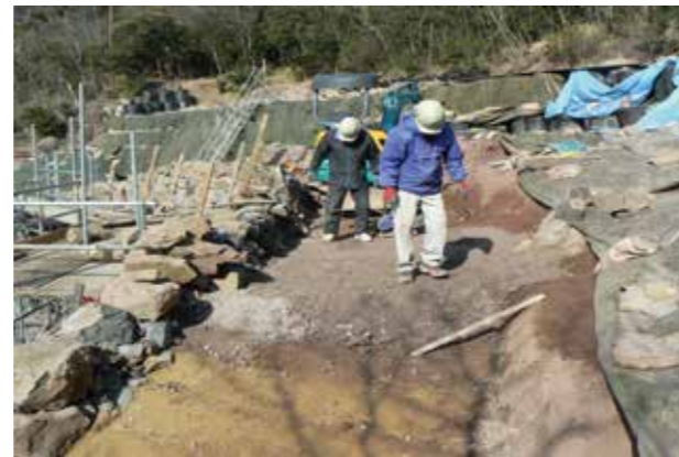
⑭背面列石施工状況
