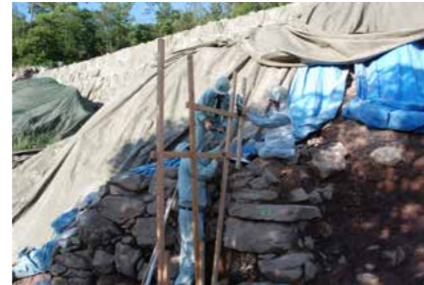
⑦丁張り（石積みの勾配）設置状況
