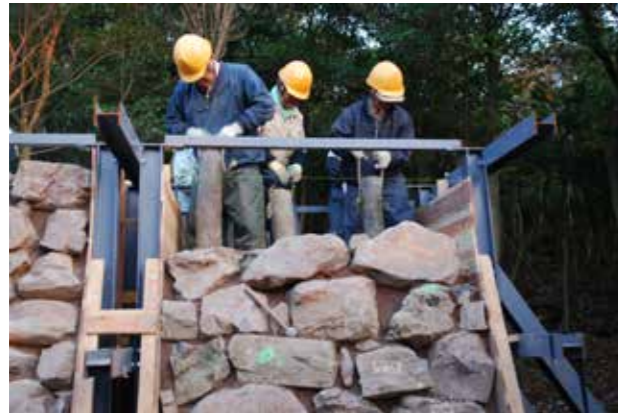
⑤城壁の試験施工
