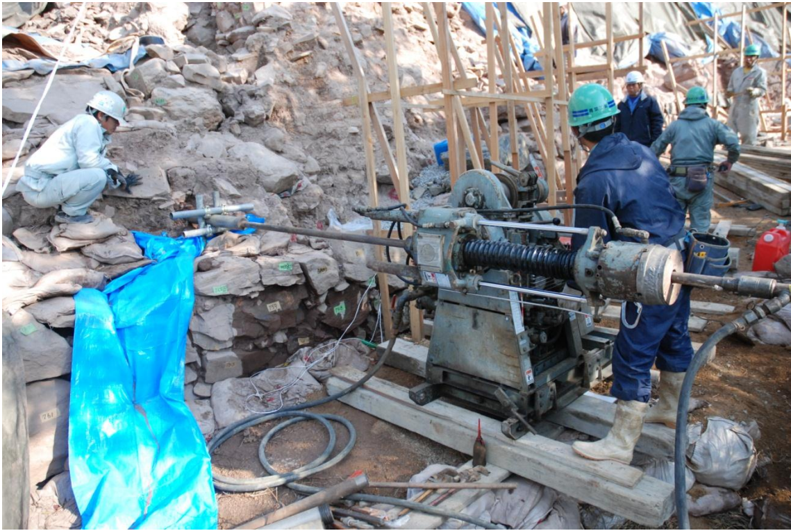
排水補強パイプ施工状況①
