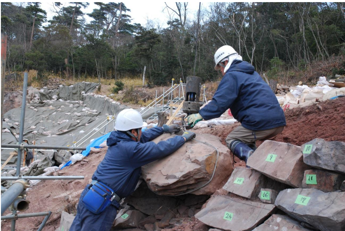
石垣の解体状況
