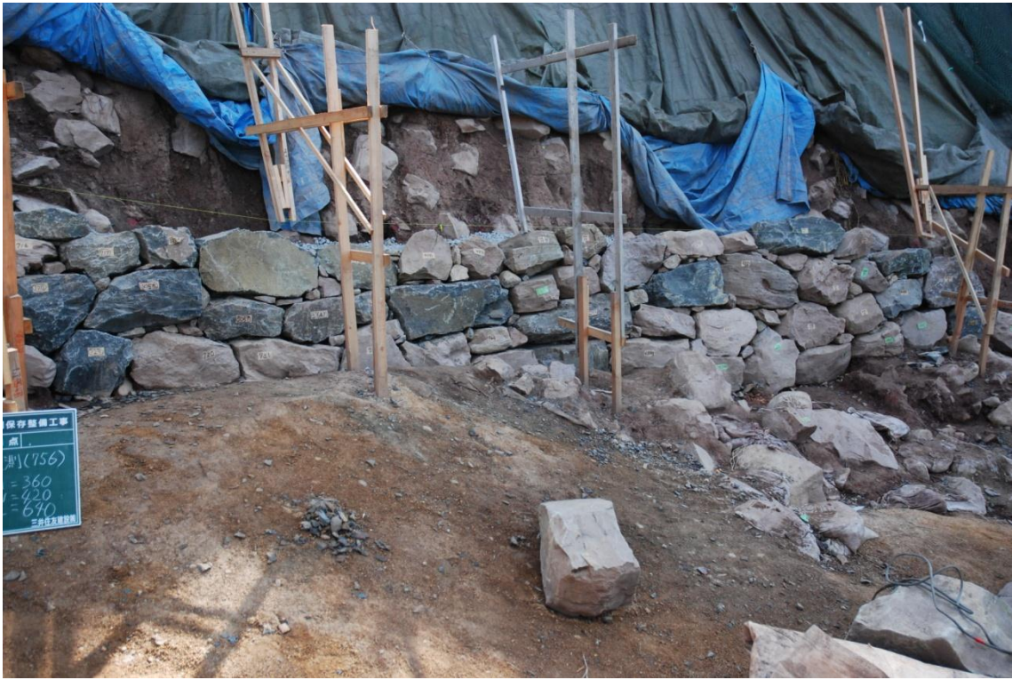
積み直された石垣
