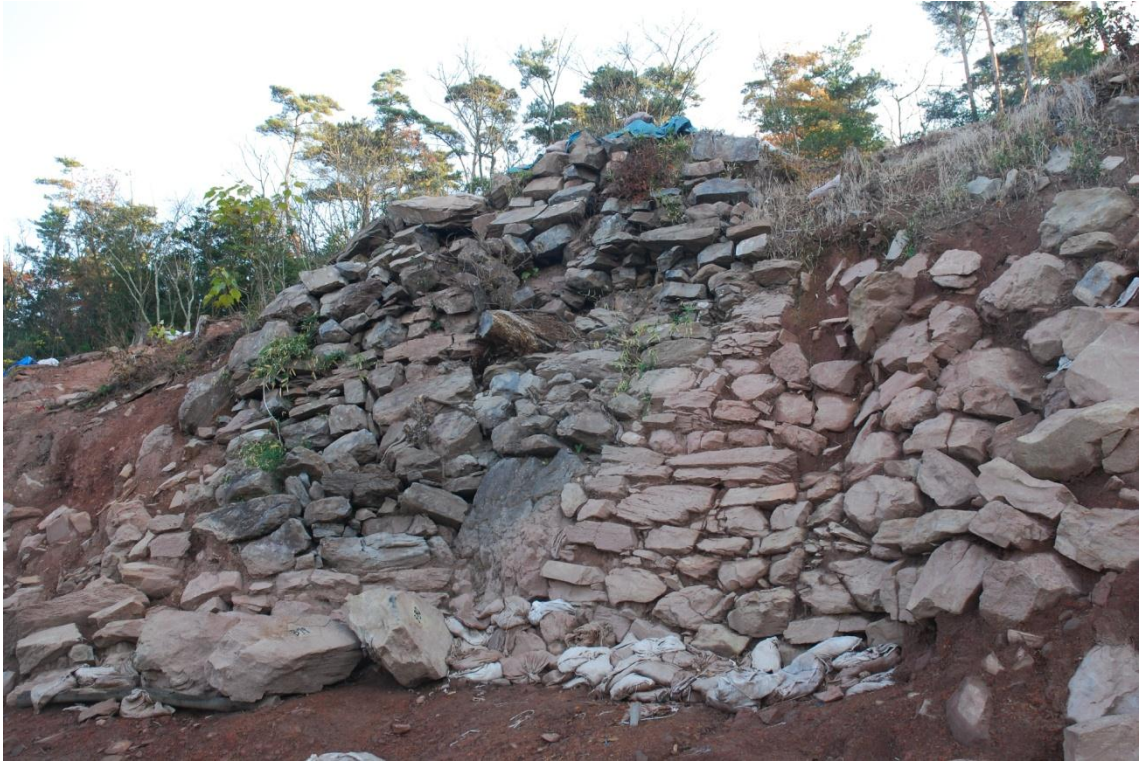
解体前の高石垣
