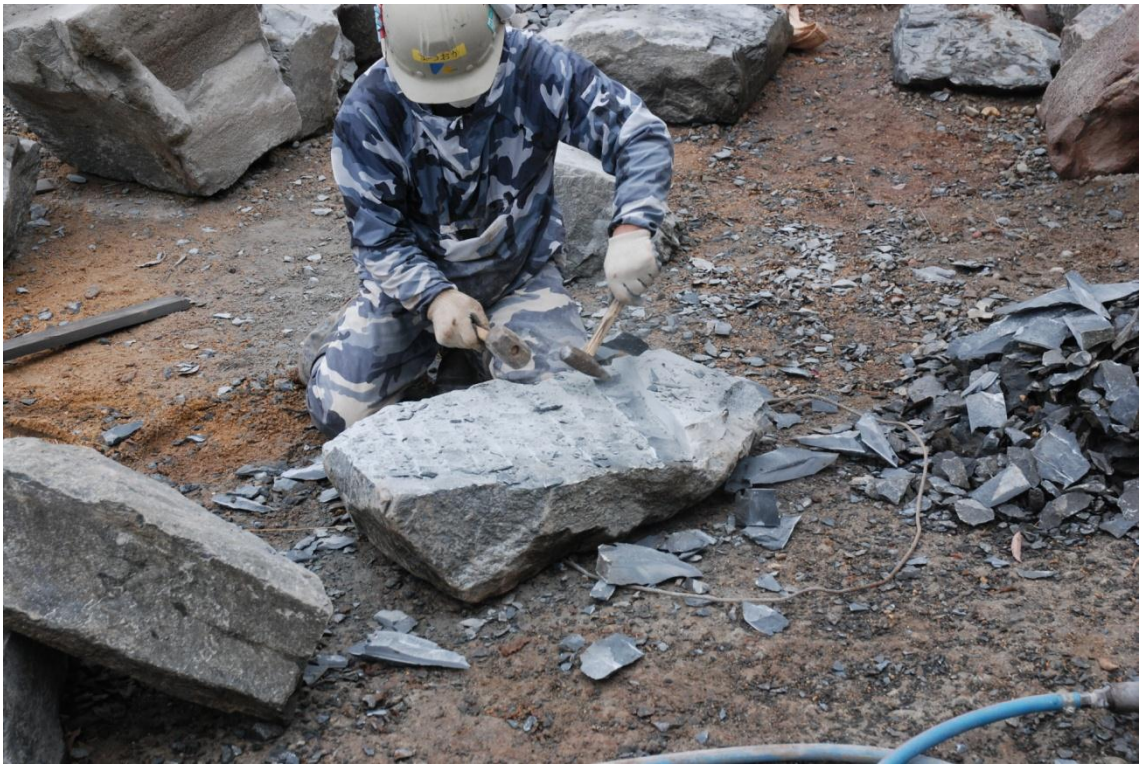
石材の加工状況
