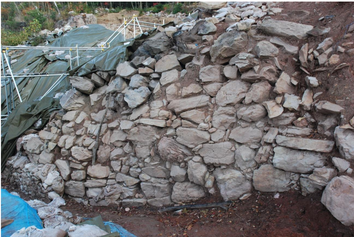
解体前の城門周辺の石垣
