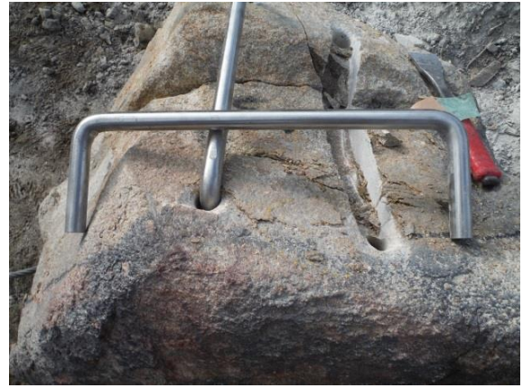
かすがいを用いた石材の接着状況
