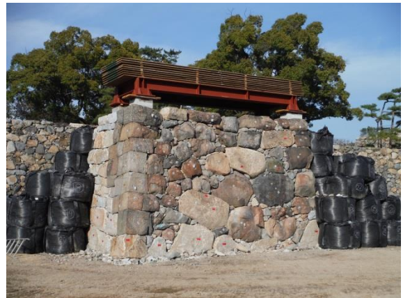
仮積み試験の状況（鉄板重量：16t強）
