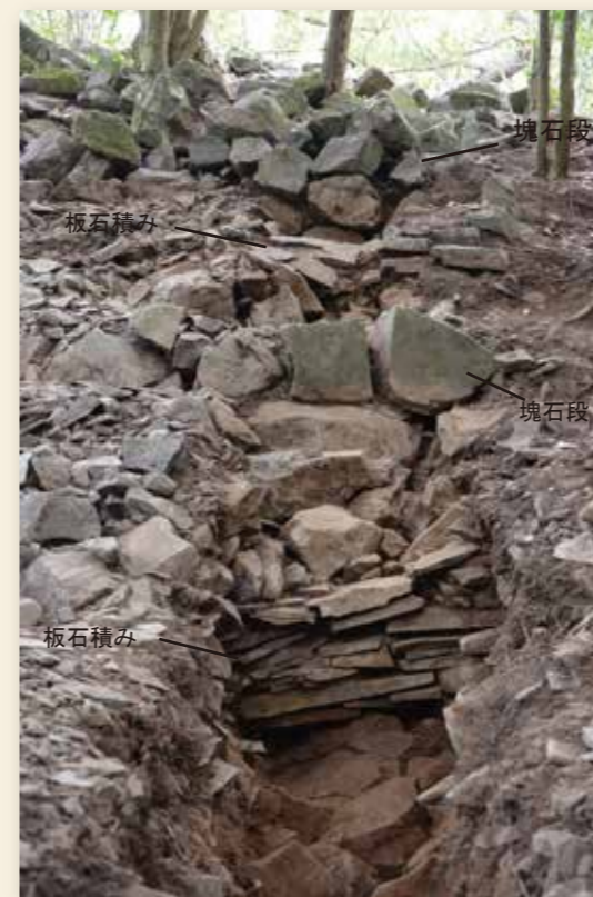
写真4 後円部南側(1tr)の石積み(南東から)
