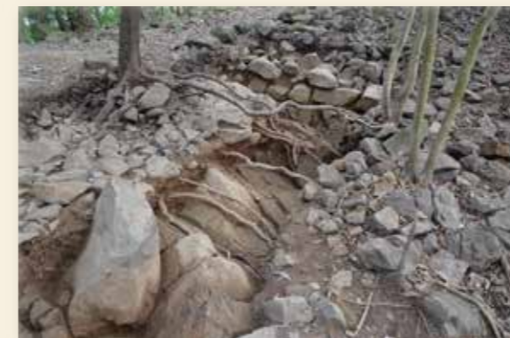
⑦ 岩盤まで西側を掘削
