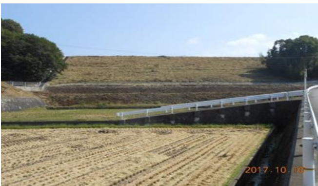
堤防の高さ28m、長さ260mある
