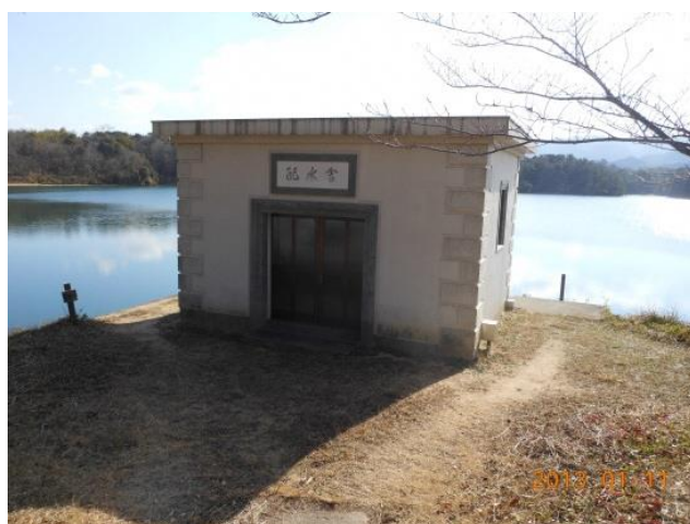
近代的な配水舎の建物
