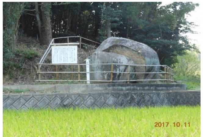
大きな割れ目が残る岩破
