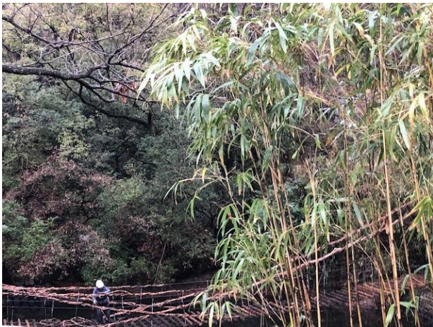
かずら橋架け替え作業の様子
