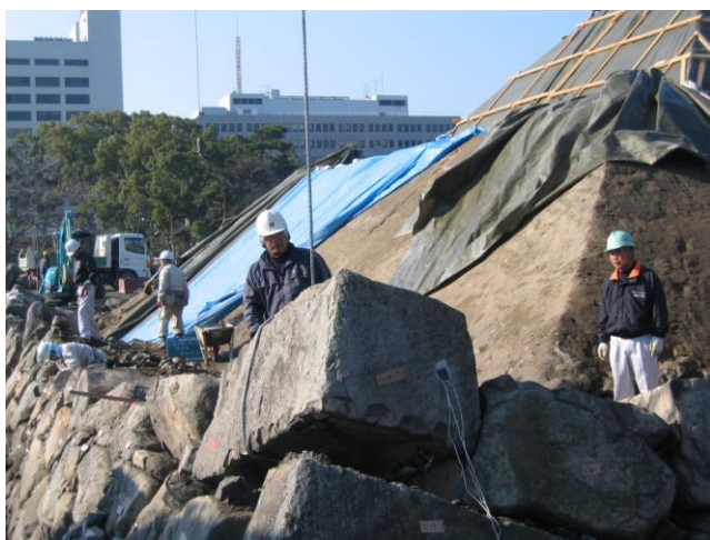
天守台石垣解体修理
