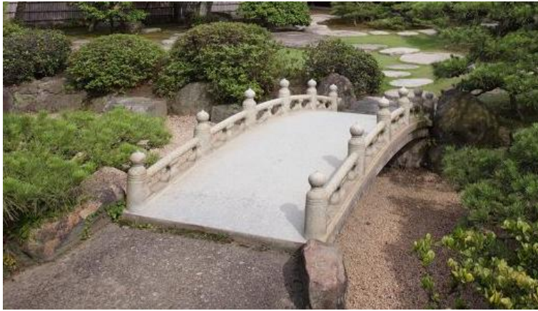
1 石の庵治石から刳り貫かれた石橋
