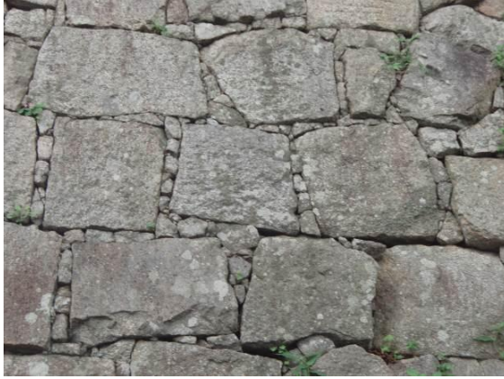
三の丸南石垣 間詰め石が丁寧に密に詰められている。
