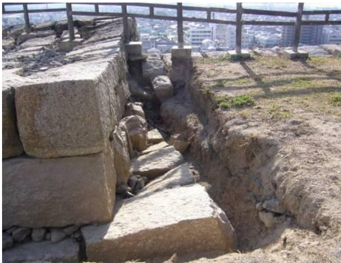
三の丸坤櫓跡の石垣の改修の跡
