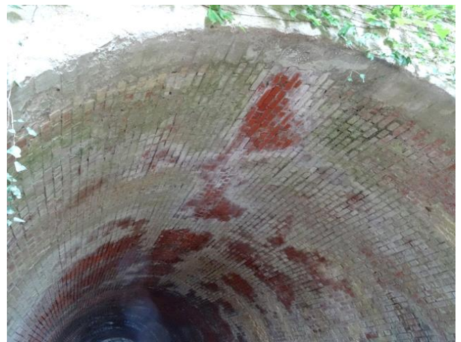
南側の坑口アーチ部 イギリス積みの様子がわかる
