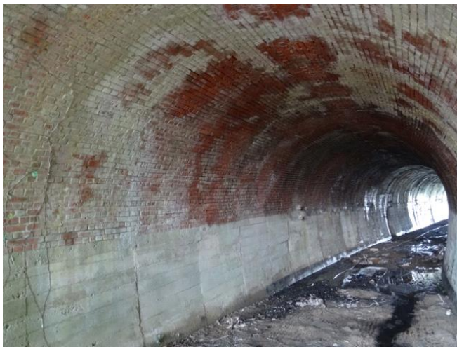
側壁とアーチ部 境目もよくわかる
