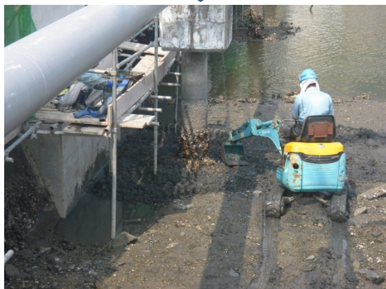
河床掘削状況
