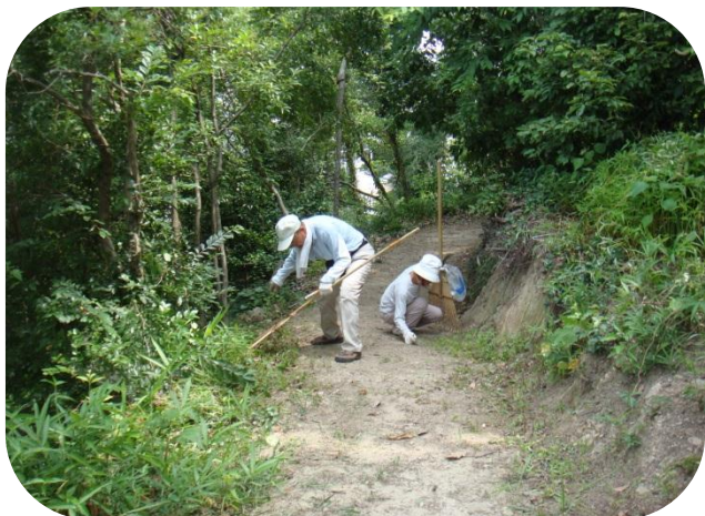
平成26年5月9日(金) ～ 遊歩道整備 ～
