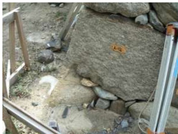
① 北東隅の隅角部
