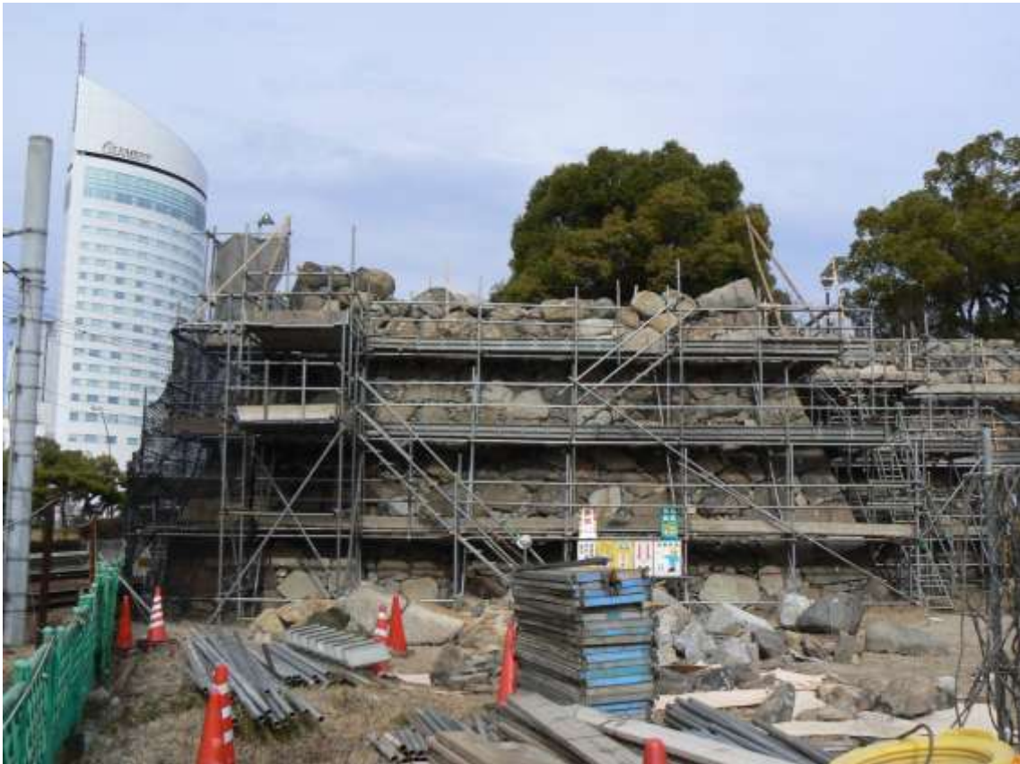
積直し完了寸前の地久櫓台（平成27年1月14日撮影）
