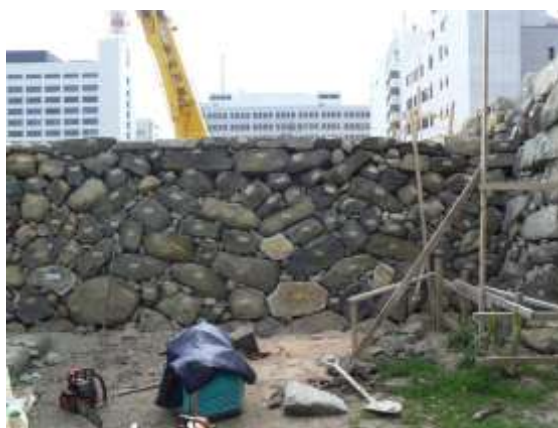
③の谷積みされた石垣
