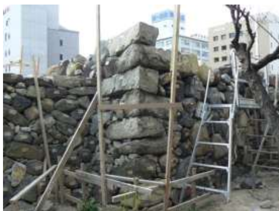
②北西隅の隅角部
